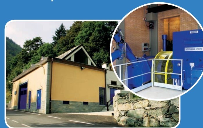
Impianto idroelettrico di Balme
