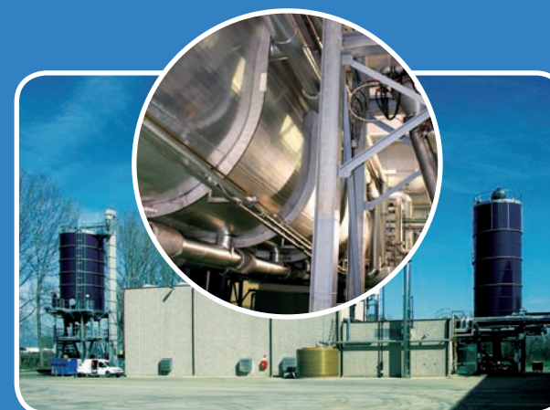
Impianto di essiccamento dei fanghi
